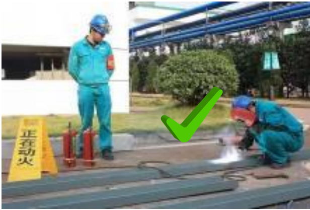
图例 32：动火作业必须落实现场看护人员
