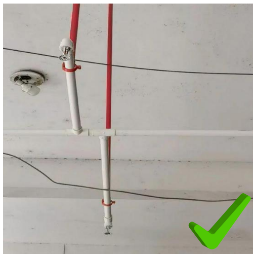
图例 17：合用场所设置简易喷淋装置
