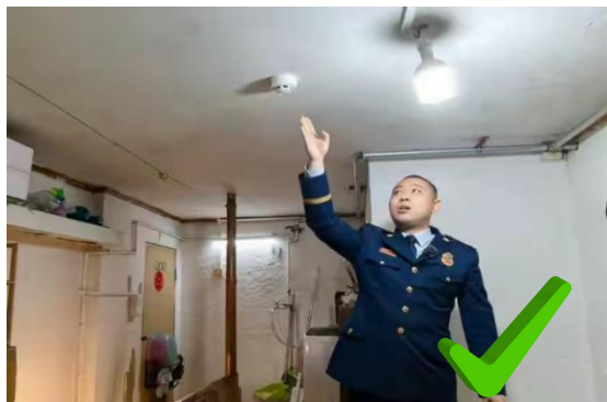
图例 13：设置独立式感烟火灾探测报警器
