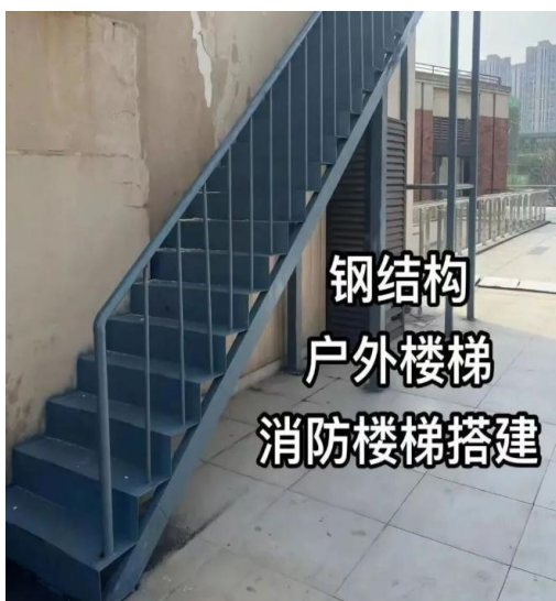
图例 19：增设室外疏散楼梯
