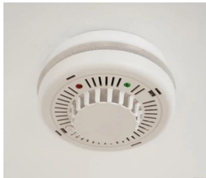
图例 14：独立式感烟火灾探测报警器
