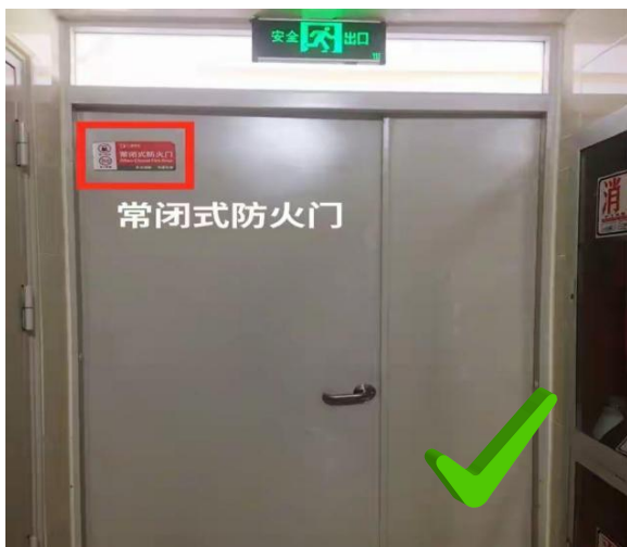
图例 16：常闭式防火门（带闭门器）
