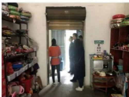
图例 7：“前店后宅”住宿部分与非住宿部分完全防火分隔
