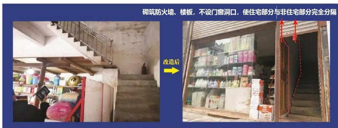
图例 8：“下店上宅”住宿部分与非住宿部分完全防火分隔
